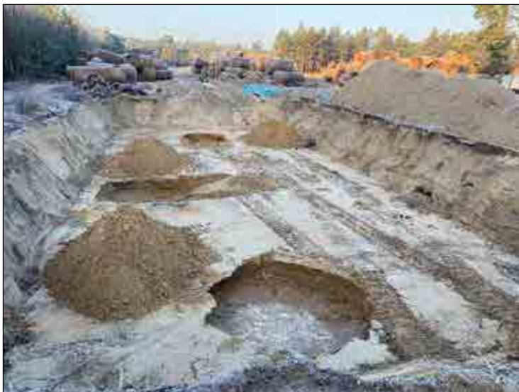
Abb. 6: Tankgrube mit Baggerschürfen (if Ingenieurgruppe Fritzsche, 2025)
