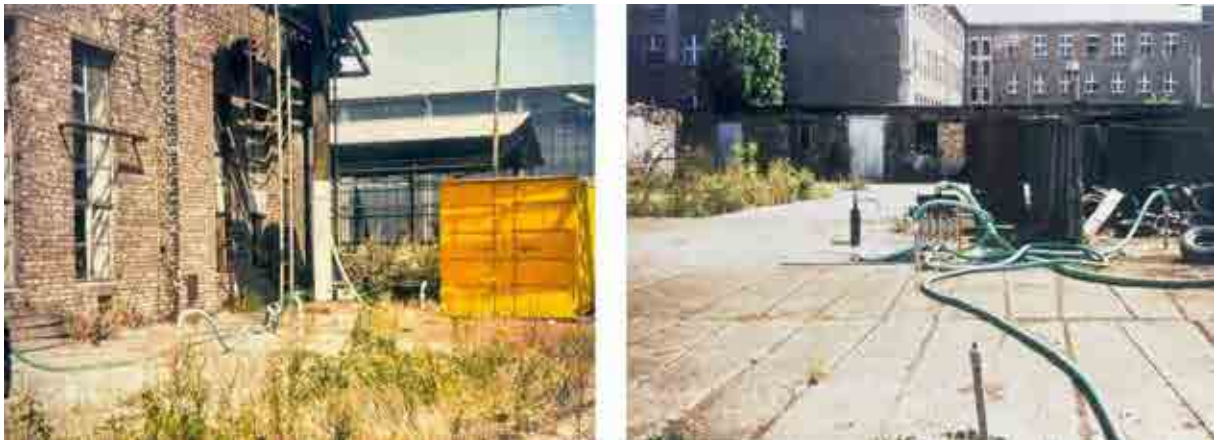
Abb. 4: links: Absaugpegel TRI-Wäsche, Seitenkanalverdichter und Aktivkohlefilter sind in einem Container untergebracht; rechts: Absaugpegel Schrottplatz, Reichweitenpegel sind über den Sammelbalken an die Absauganlage angeschlossen, TAUW [3]
