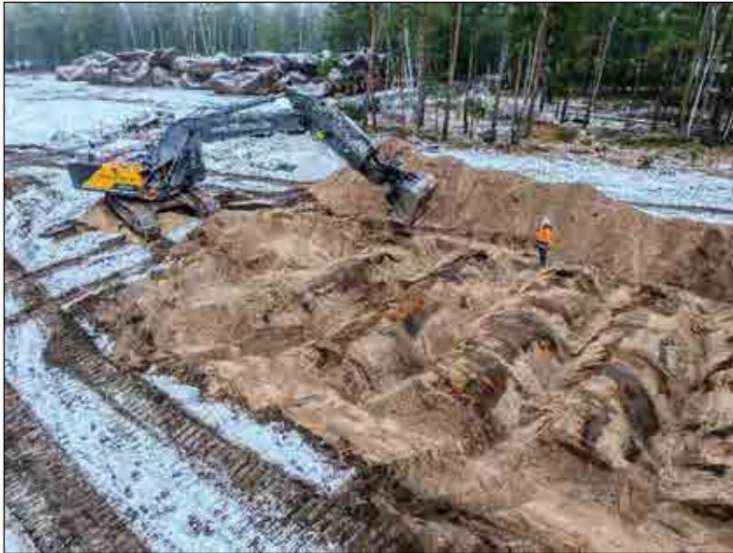
Abb. 5: Tankbergung mittels 60 t – Kettenbagger (BlmA, 2025)
