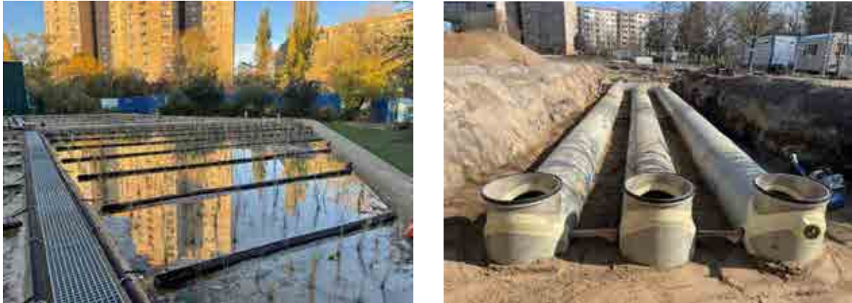
Abb. 4: Vertikaler Bodenfilter sowie Stauraumkanal (Quelle: Mientus & Rauch, 2023)
