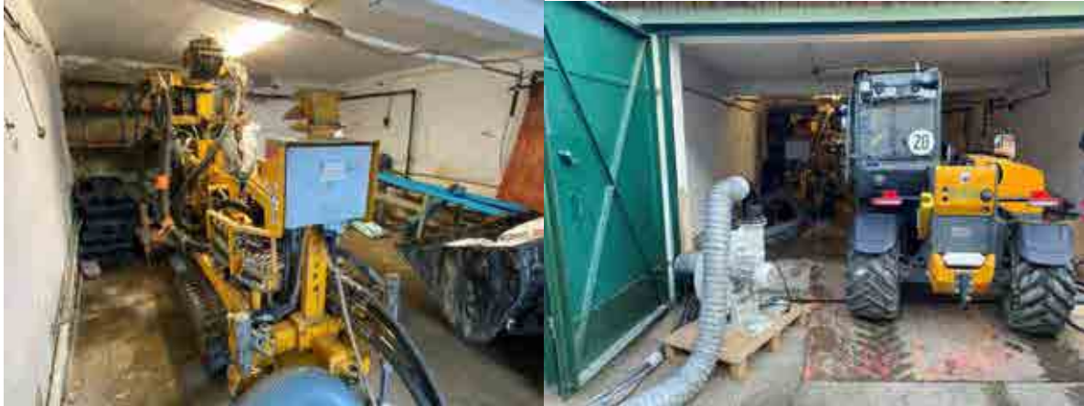
Abbildung 5: Bohren und Ausbau von Air-Sparging-Brunnen bei Raumhöhe von 2,30 m.
