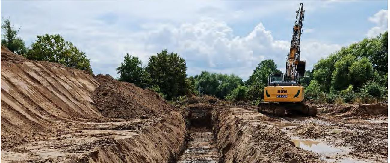
**Abb. 5: BA 1: Baggerschurf im BA 1 und teilweiser Bodenaustausch**
