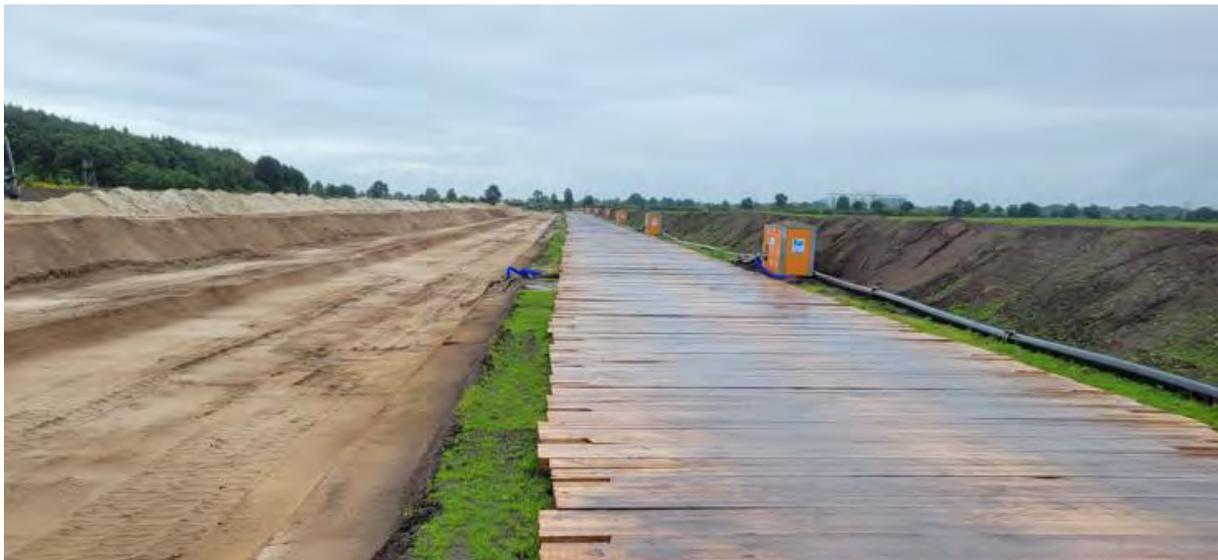
**Abb.3: Beispiel für lastverteilende Maßnahmen zum Schutz des Bodens im Bereich der bauzeitlichen Baubedarfsfläche (hier: Einsatz von sog. Baggermatratzen aus Buchenholz)**
