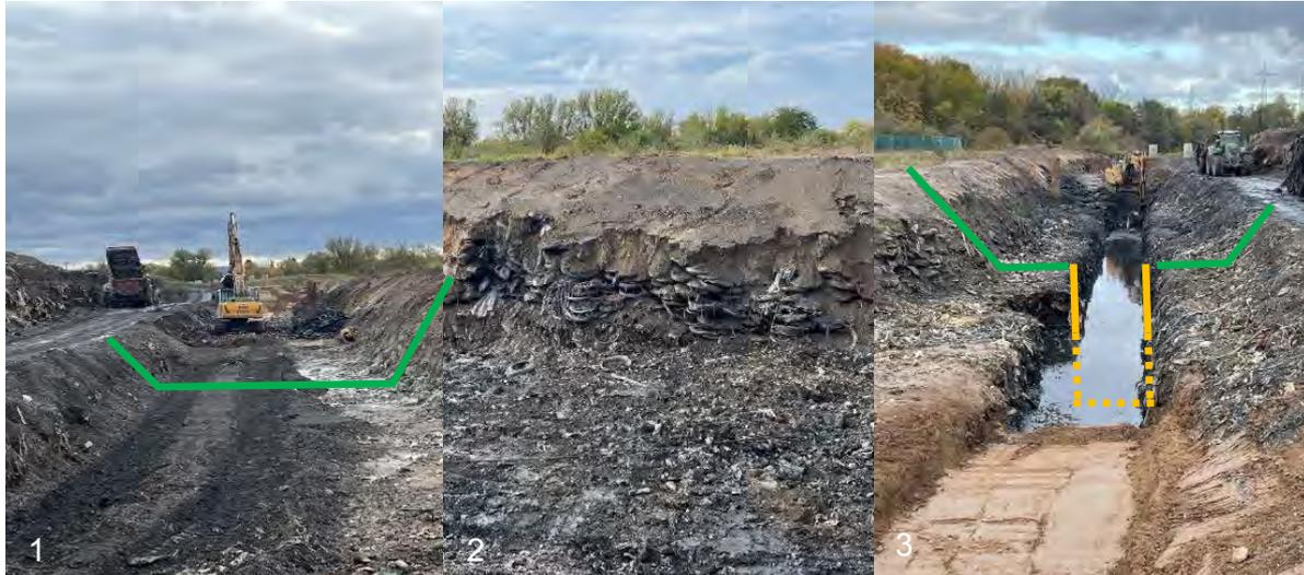
Abb. 8: BA 4: 1 Voraushubebene, 2 Reifenlage, 3 Tiefenaushub
