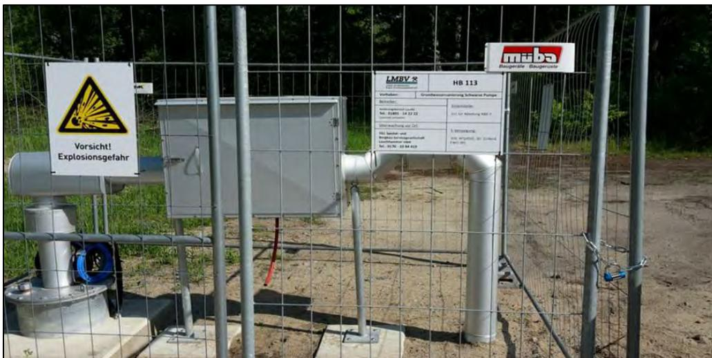
Abb. 8 Beispiel: explosionsgeschützt hergerichteter Brunnen, hier HB 113 (errichtet 2017) [QV]
