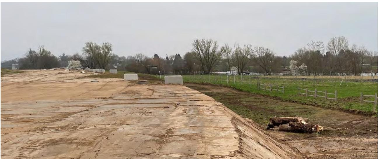
**Abb. 7: BA 3: Damm mit gesicherten Grundwassermessstellen**
