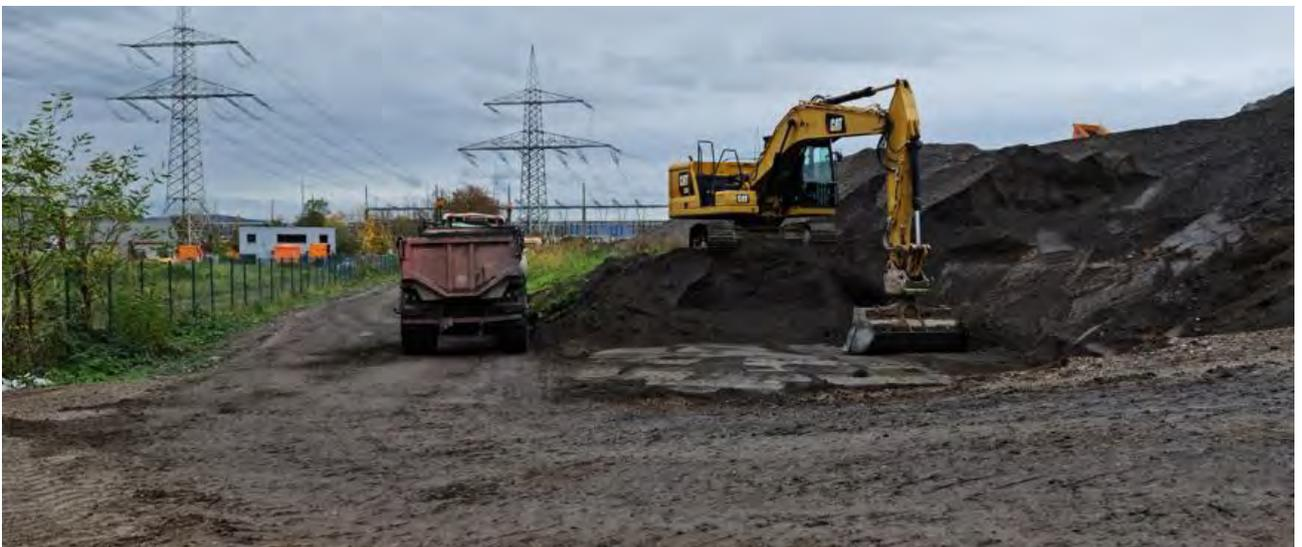
**Abb. 6: BA 2: Abtrag zur Herstellung der Umfahrung am nördlichen Rand**
