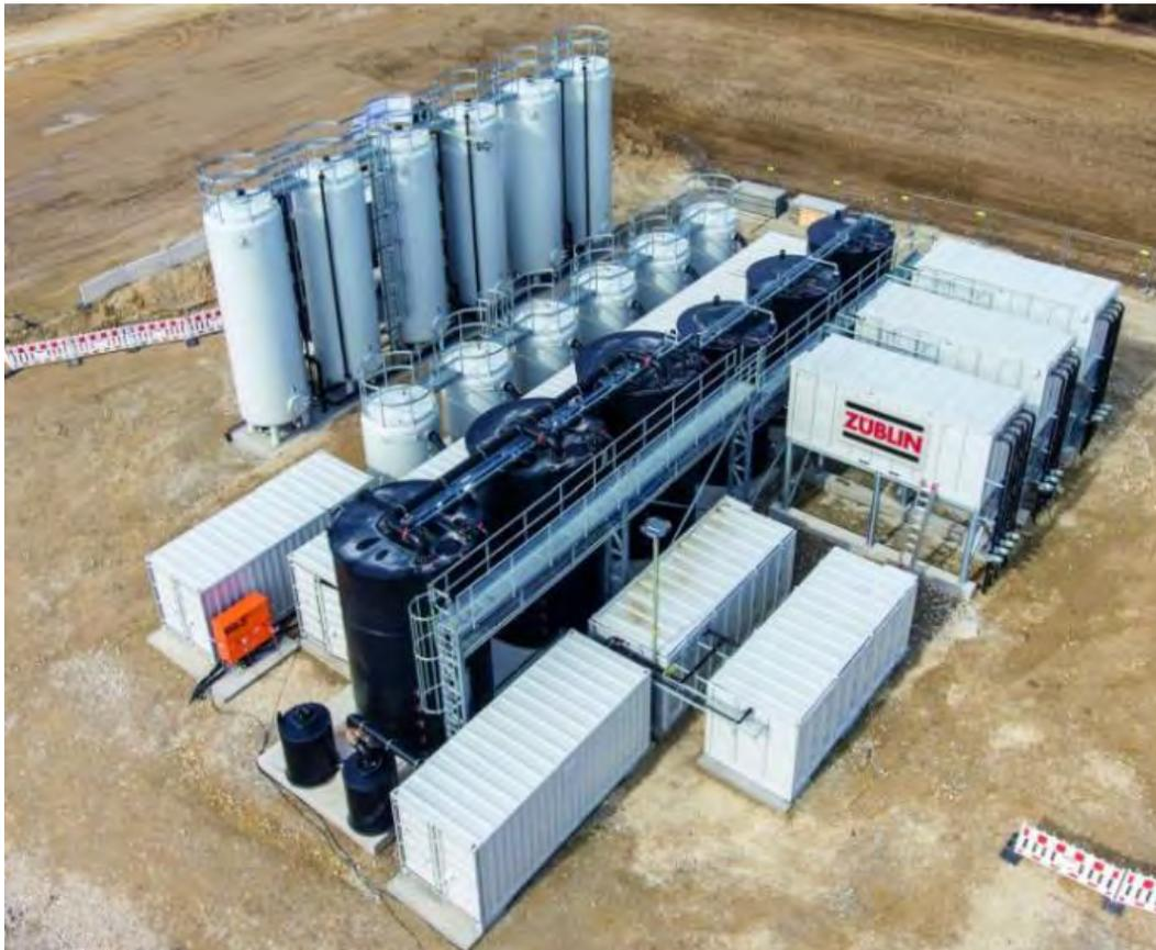
Abbildung 1: GWAA als Abstomsicherung am incampus Gelände Ingolstadt [Quelle: Züblin Umwelttechnik]
