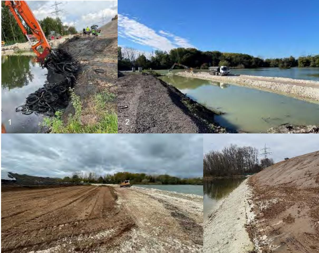
**Abb. 10: BA 6: 1 Entfernung der Störstoffe auf dem Seegrund, 2 Einbau der Vorschüttung aus Grobschlag, 3 Verfüllung des Dambeckens, 4 Dammaufbau**
