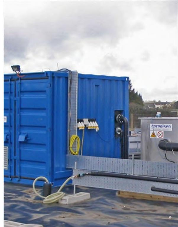
MPE-Schlürfbrunnen mit Schlauchverbindung zur MPE-Anlage (Quelle: Q. Hulm, 2017)
