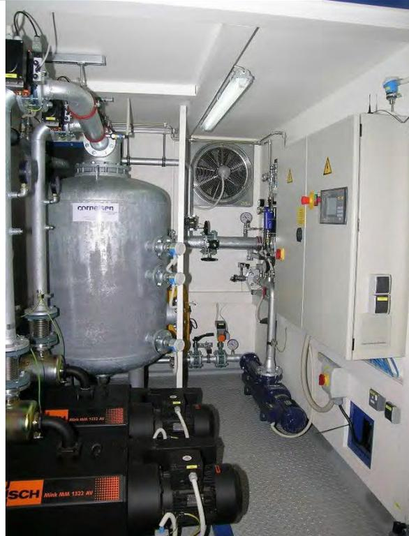
MPE-Anlage nach ATEX-Standard, eingebaut in 10'-Container (Quelle: M: Cornelsen, 2018)
