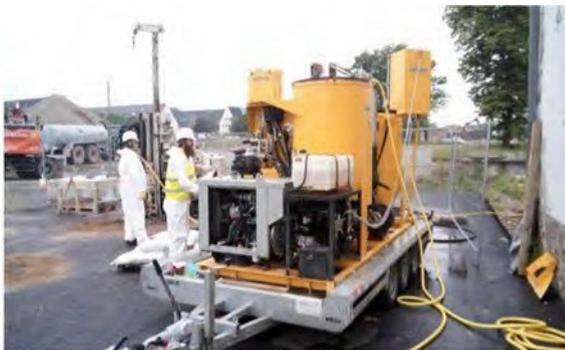
Verpressung von EHC Feststoff Reagenzien (Zellulose mit nullwertigem Eisen) im Schadensherd mittels TSE® Injektion
