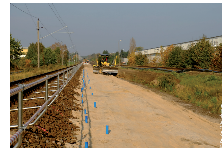
Abb. 4: Bohrlochreihen zur Sondierung entlang einer Bahnstrecke
