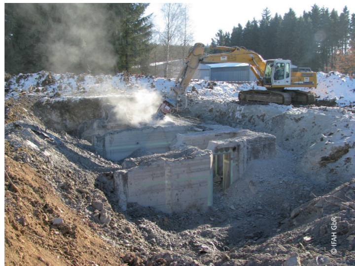
Abb. 5: Abbruch eines freigelegten Bunkers einer ehemaligen Munitionsanstalt
