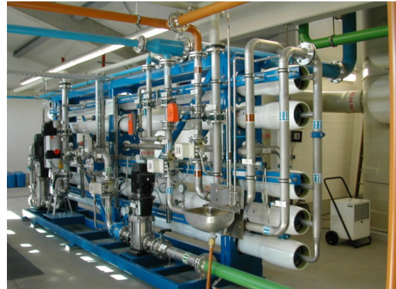
Abb. 22: Nanofiltrationsanlage
