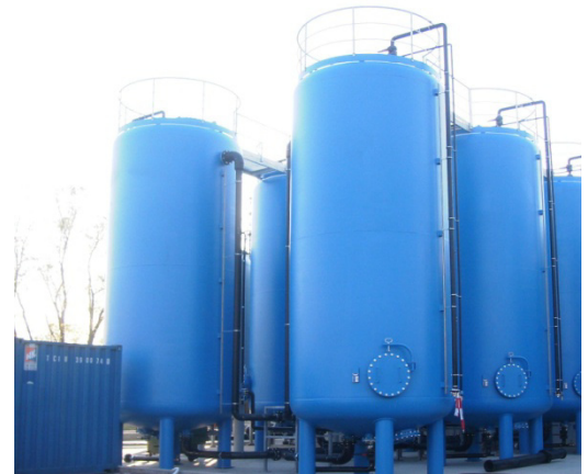
Abb. 36: Mehrstufige Aktivkohlefiltration
