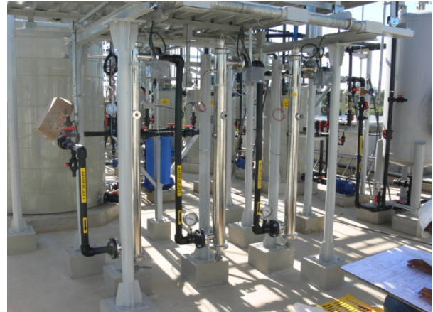
Abb. 28: UV-Photooxidationsanlage zur Behandlung von Grundwasser
