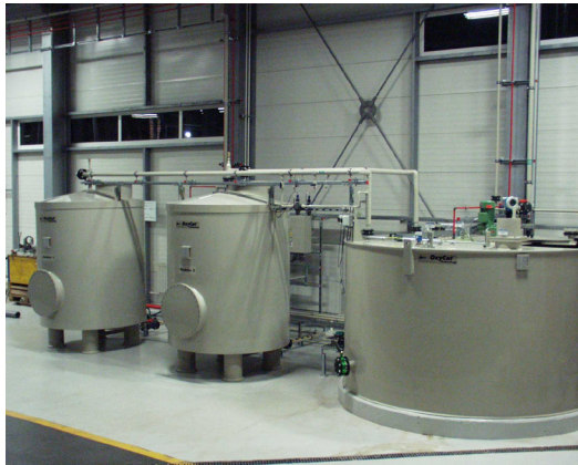
Abb. 31: Anlage zur katalytischen Oxidation
